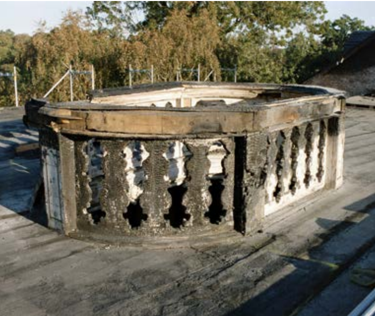
Die Brüstung des Deckenauges auf der berühmten Brandebene des historische Bibliotheksgebäudes unter freiem Himmel im Jahr 2004
