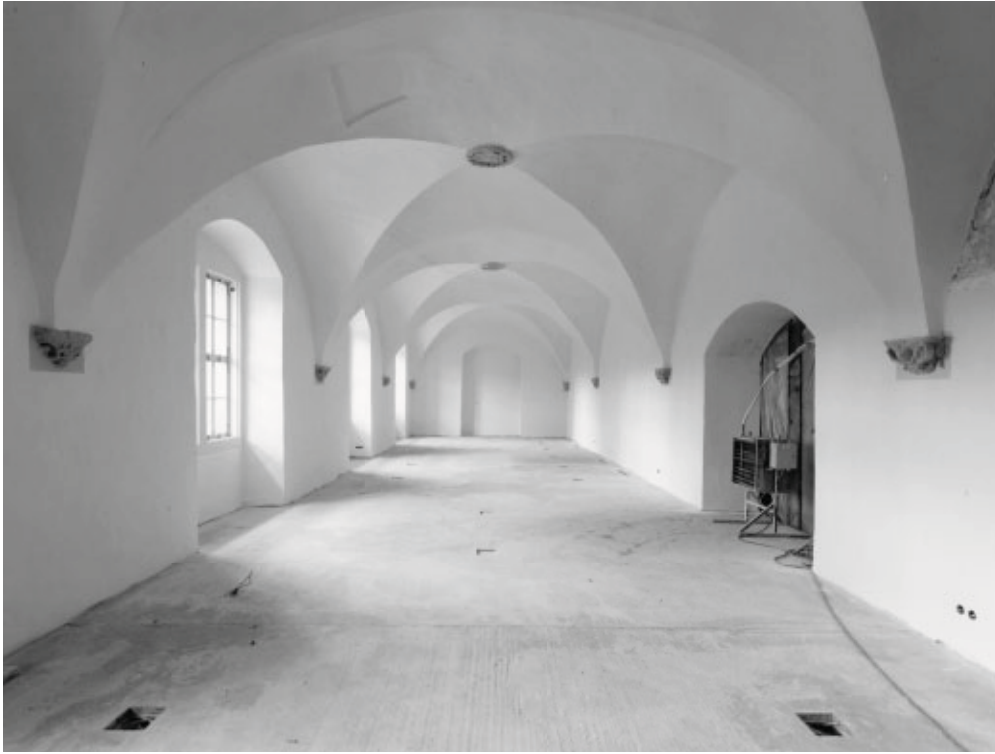
Sanierung des Renaissancesaals, 2006
