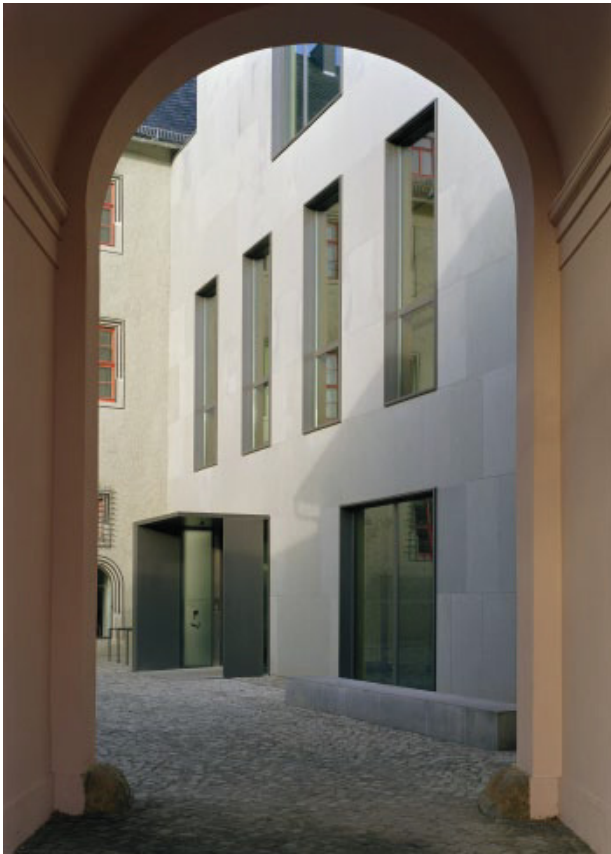
Blick zum Haupteingang Studienzentrum
